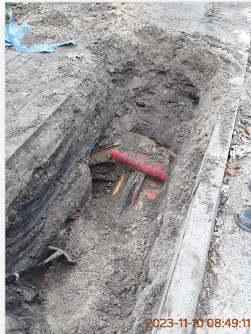
Uszkodzenie kabla 15kV przy wykonywaniu przewiertu dla przedsiębiorstwa z branży gazowniczej
