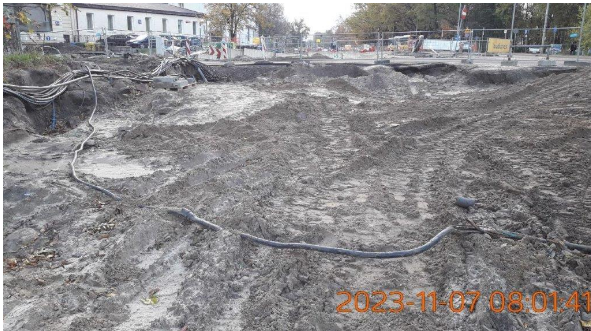
Budowa torów tramwajowych i układu drogowego
